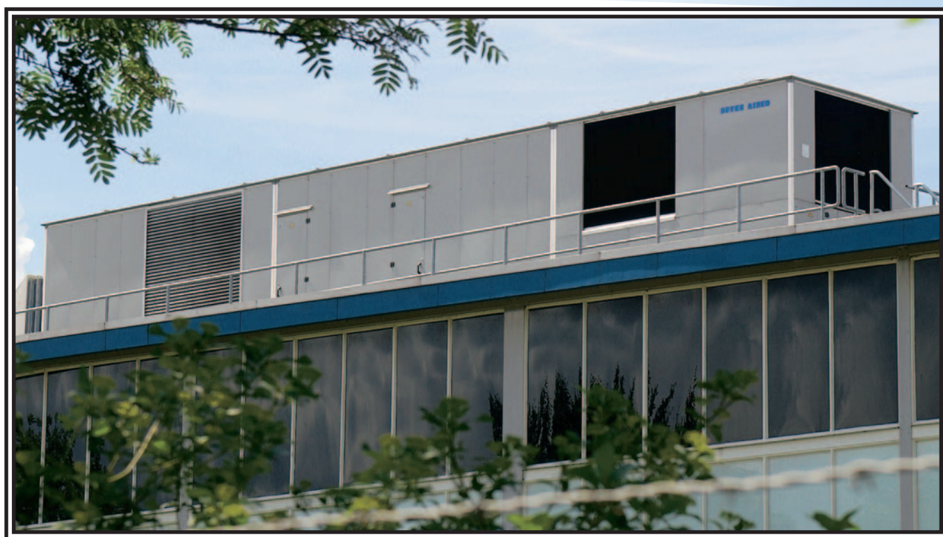
Dakcentrale type BDK60S-III, opgesteld bij Philips te Eindhoven Gevuld met koudemiddel R-407C
