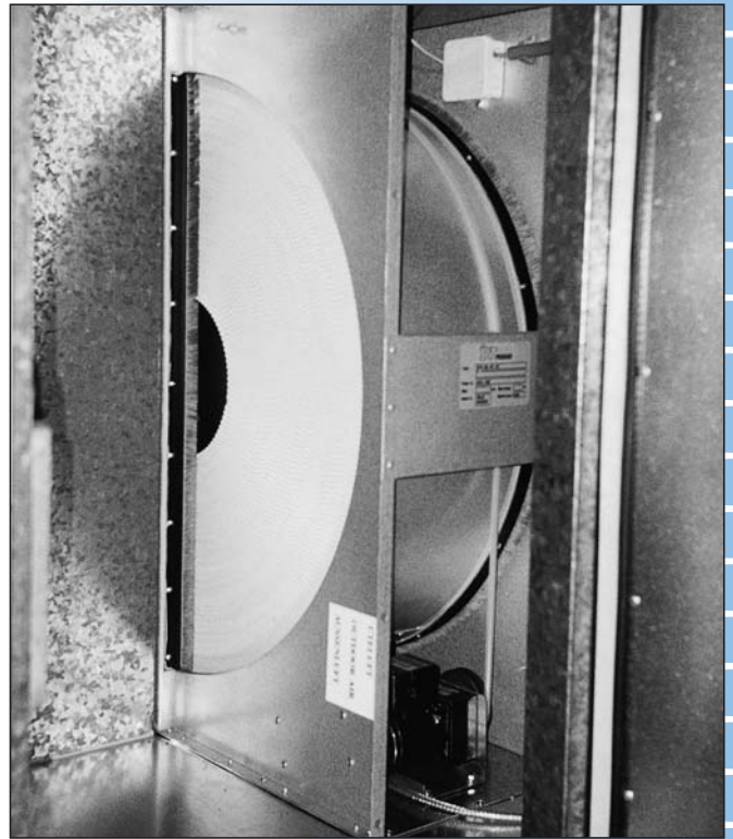
Roterende warmtewisselaar met hygroscopische laag en toerengeregelde aandrijfmotor.
